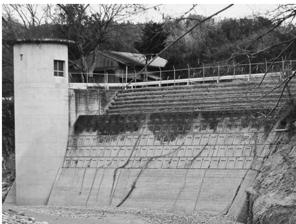
第1図 擁壁に残る濁流跡 青岩公園
